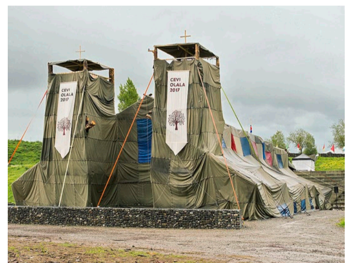
Das Münster: Holzkonstruktion mit 500 Militärblachen
